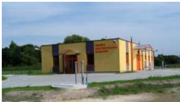
Rys. Nr 1 Oczyszczalnia ścieków w Widzowie
